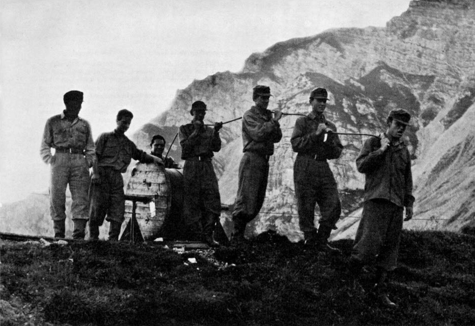
Kabellegung am Birgitzköpfl
