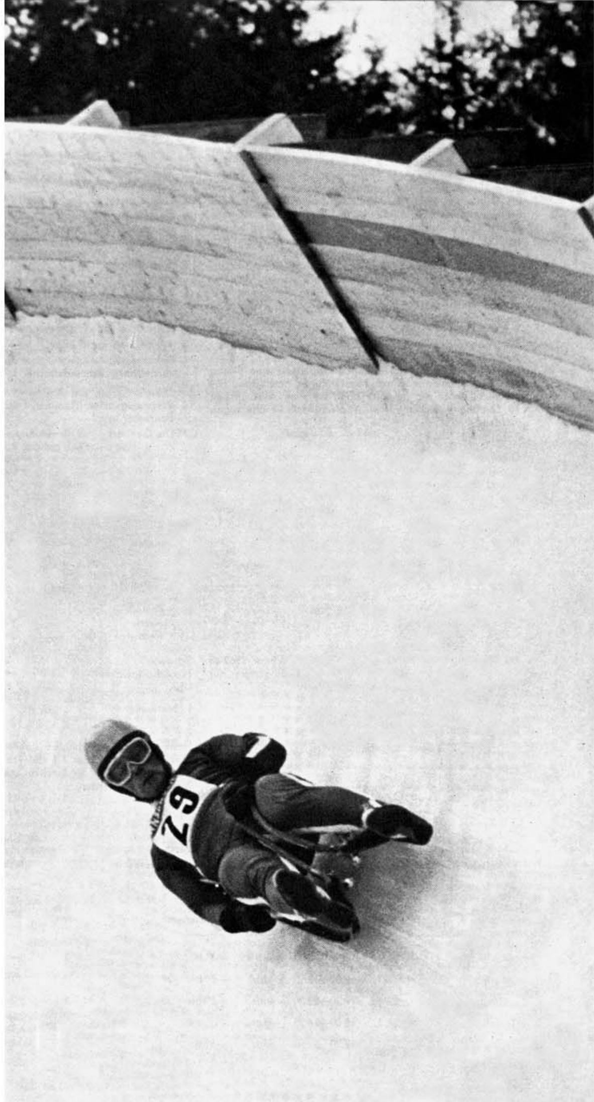
Um Stürze über die Bahn hinaus zu vermeiden, wurden in den Kurven auf die Krone der Rodelbahn hölzerne Abweiser gesetzt
