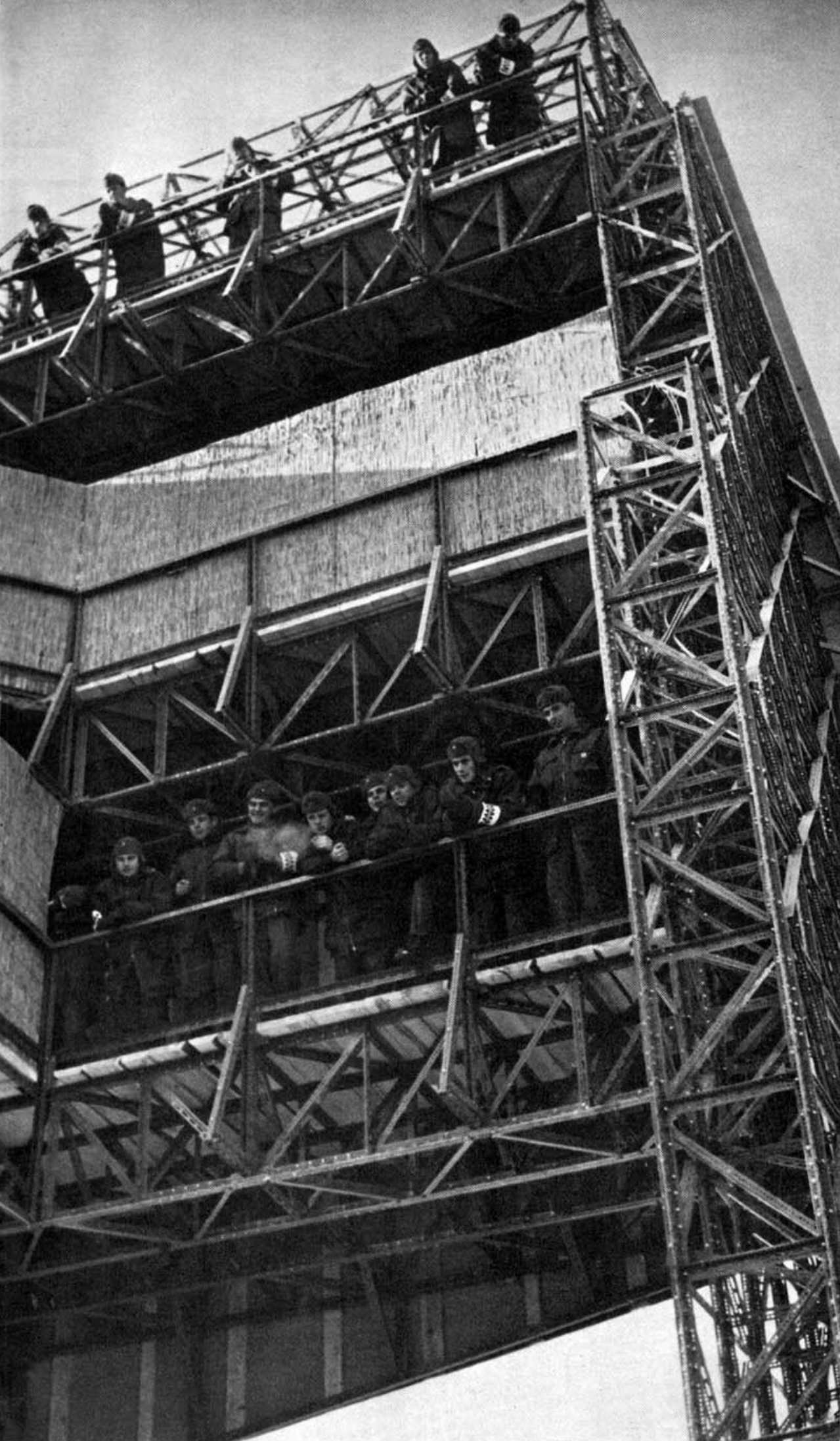
Die in „Dexion-Bauweise“ errichteten, zum Teil riesigen Aufzeigetafeln wurden von Bundesheer- angehörigen bedient
