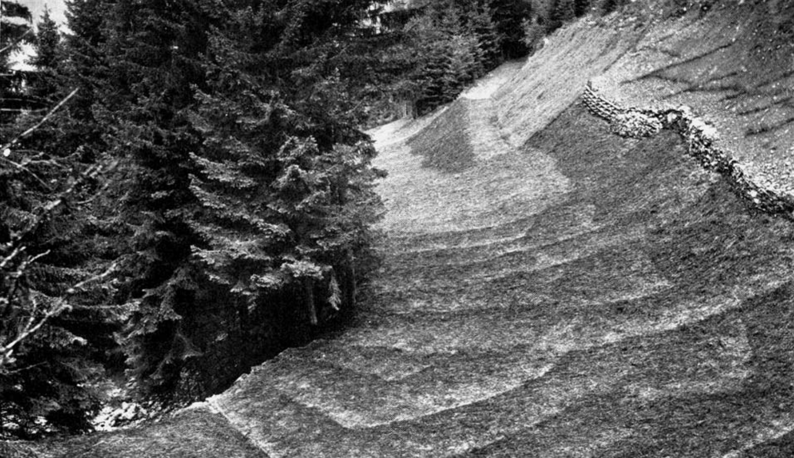
Das Begrünungsverfahren „Saat auf Stroheckschicht“ garantierte eine rasche Berasung auf allen Wettkampfstätten
