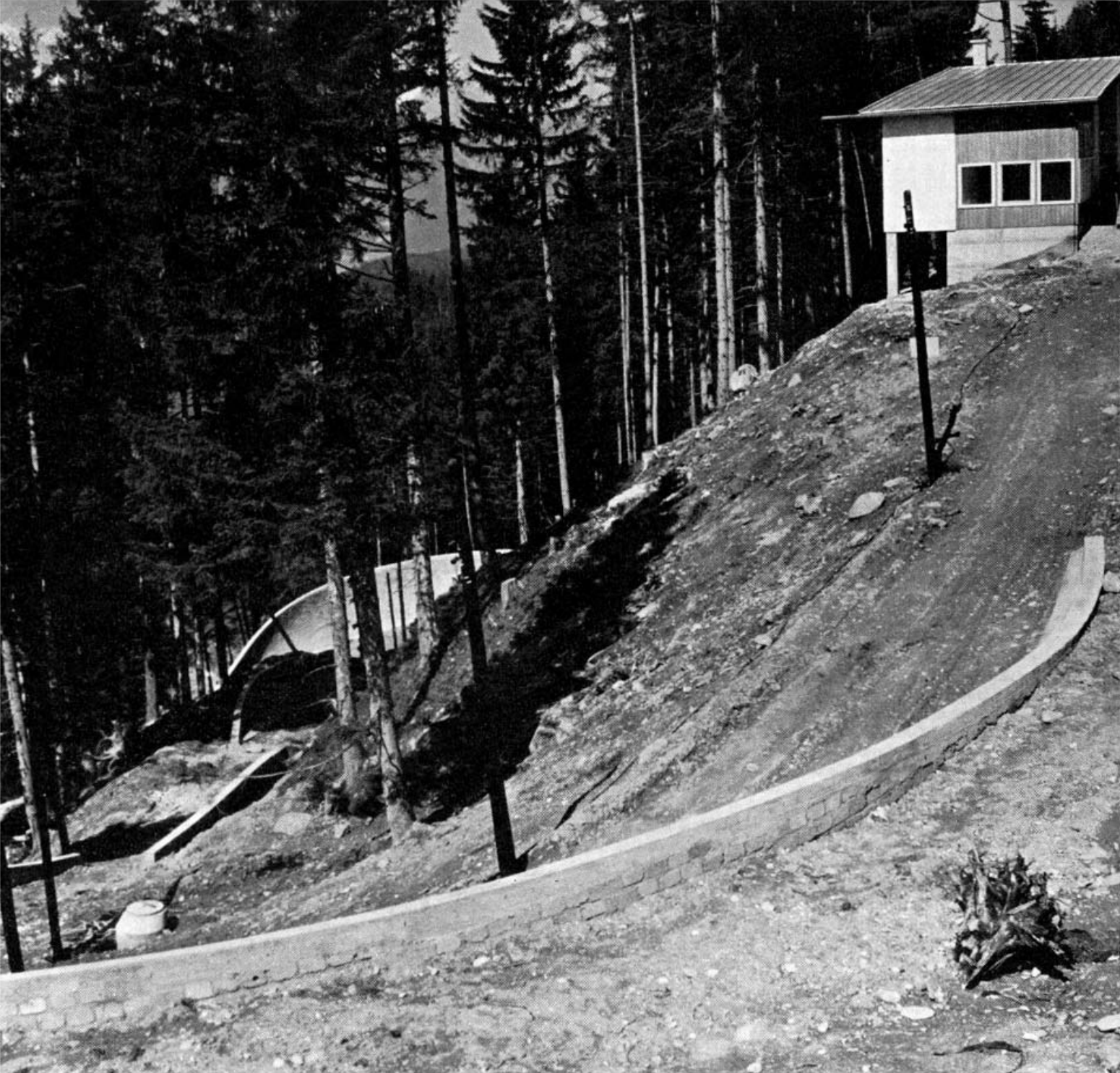
Eine sehr interessante und kühne Konstruktion stellt die Olympiarodelbahn in Igls dar
